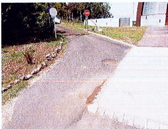
Photo 1 – Lors de grosses pluies les EP dévalent de cette rue attenante à l'Église.
