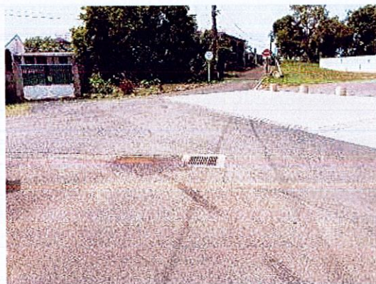
Photo 2 – Le regard EP tel qu'il est placé n'intercepte pas les EP dévalant de la rue attenante.
